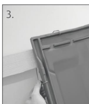
3. Fissare l'estremità della clip al lato della tegola
