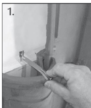
1. Posizionare la clip nella parte più alta della tegola
